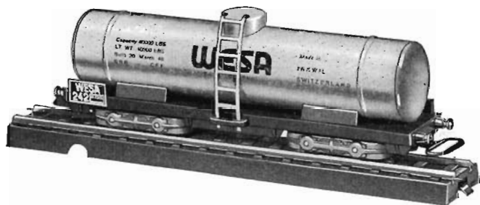
242 N Zisternenwagen, Zisterne blau, 13 cm lang, schwarze Aufschrift WESA, blanke Leiter, schwarzes Chassis, graue Drehgestelle, vierachsrig, Kupplung am Drehgestell, Puffer
